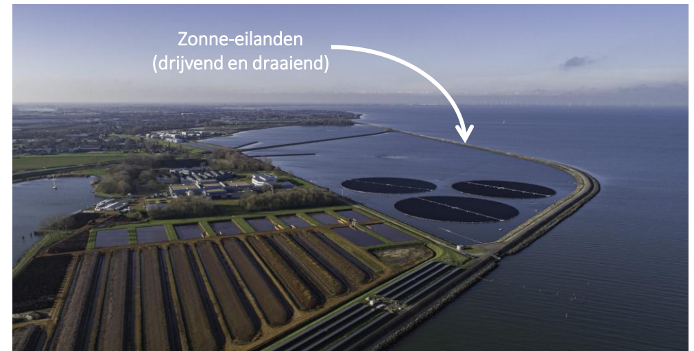
De productielocatie van PWN in Andijk beschikt over drie draaiende, drijvende zonnevelden op de spaarbekkens.
